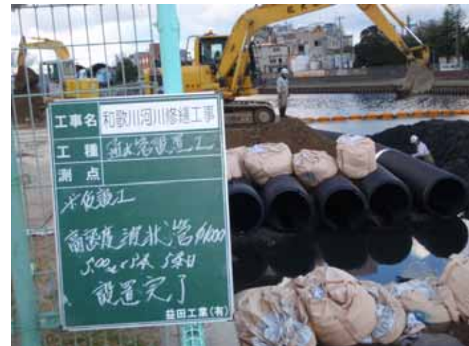
仮設通水路設置状況
