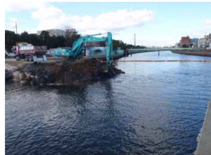
仮堰掘削状況
