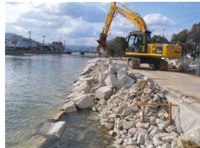
被覆石据付状況
