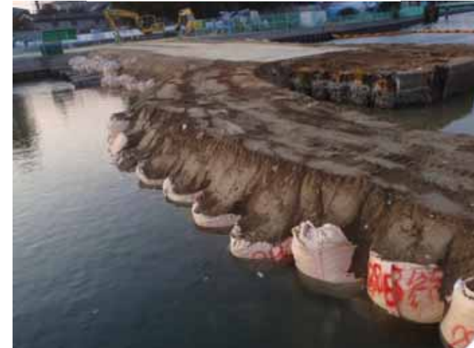
仮設盛土(仮締切)完了状況
