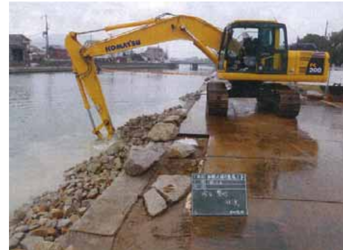
捨石投入状況
