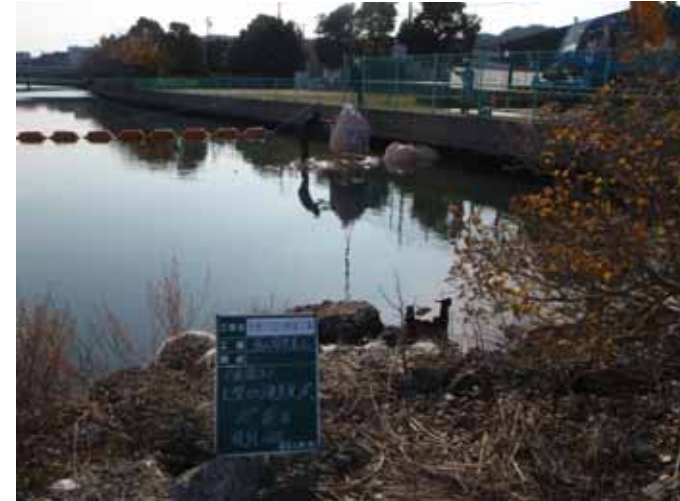
大型土のう設置状況
