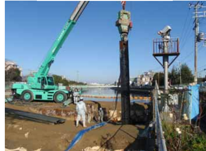
水門基礎矢板の撤去状況
