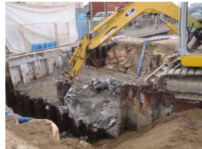
水門底板コンクリート取り壊し状況
