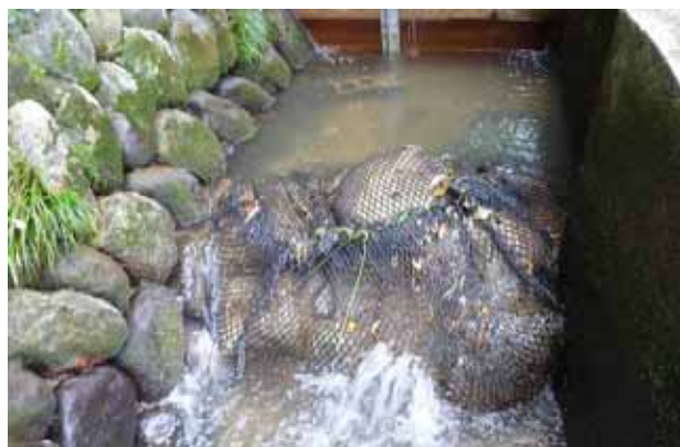
上流側隔壁間土のう(流失なし)
