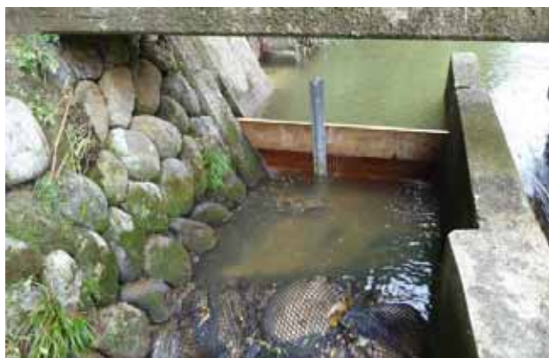
隔壁(流失なし)
