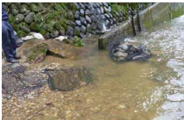
魚道入り口部土のう(流失なし)
