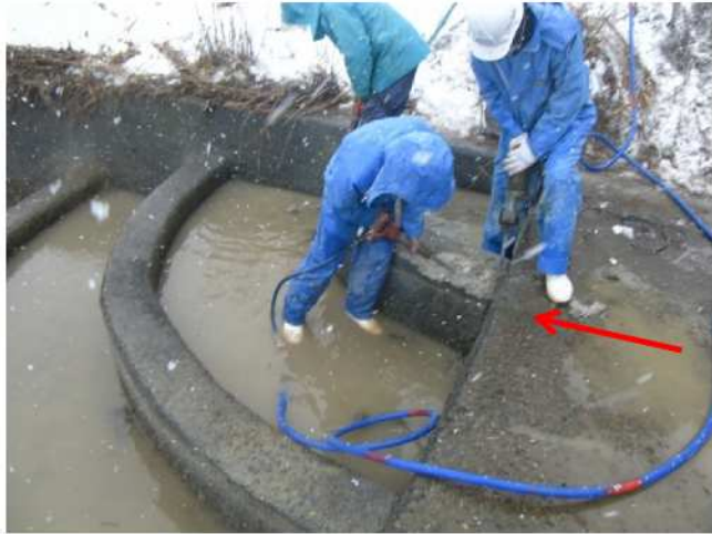
はつり(隔壁両端)作業
