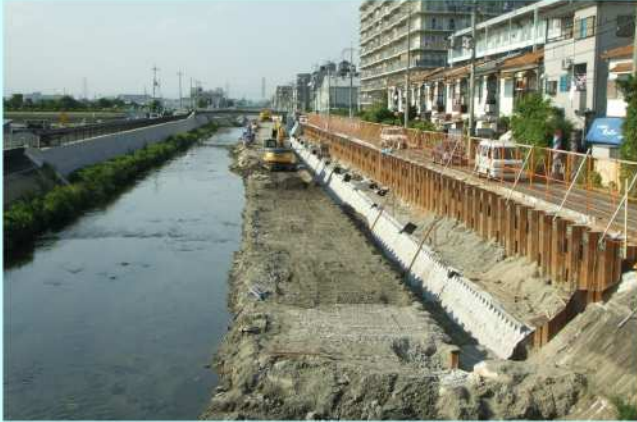
●河道改修(恩智川)
