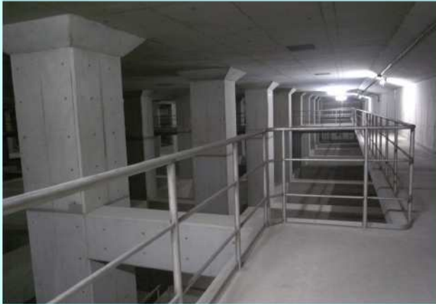
●流域調節池(八戸ノ里調節池)
