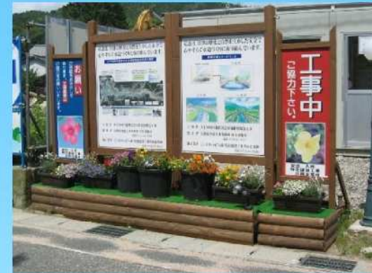
工事内容掲示板
