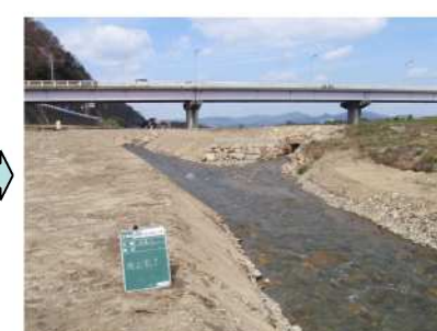
魚道合流部完了
