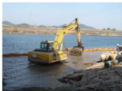
堆積土砂撤去
