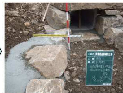
吐口石張設置(胴込完了)
