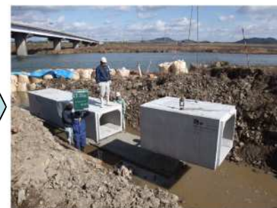
カルバート設置
