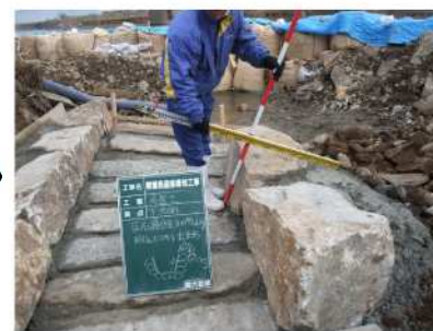
受口石張設置(胴込完了)
