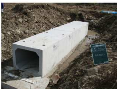
カルバート設置完了
