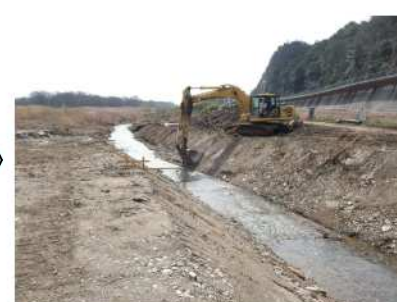
魚道合流部法面整形
