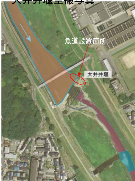
大井井堰空撮写真
