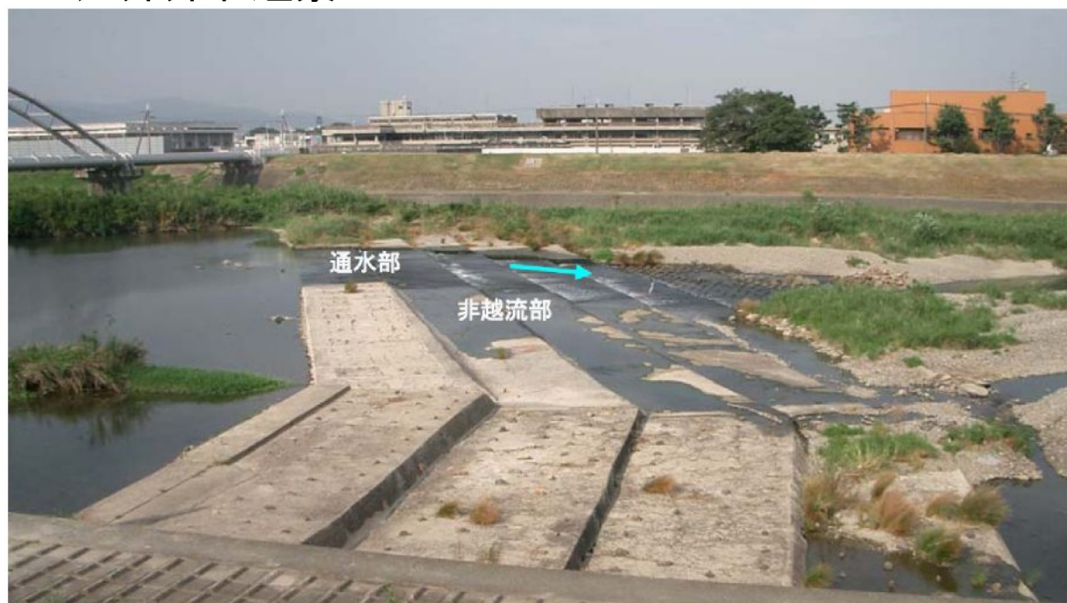
大井井堰遠景
