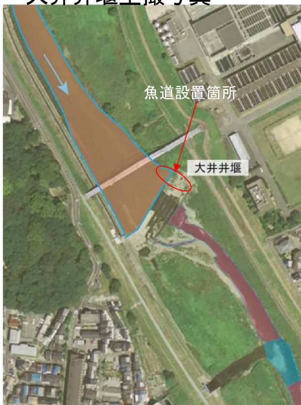
大井井堰空撮写真
