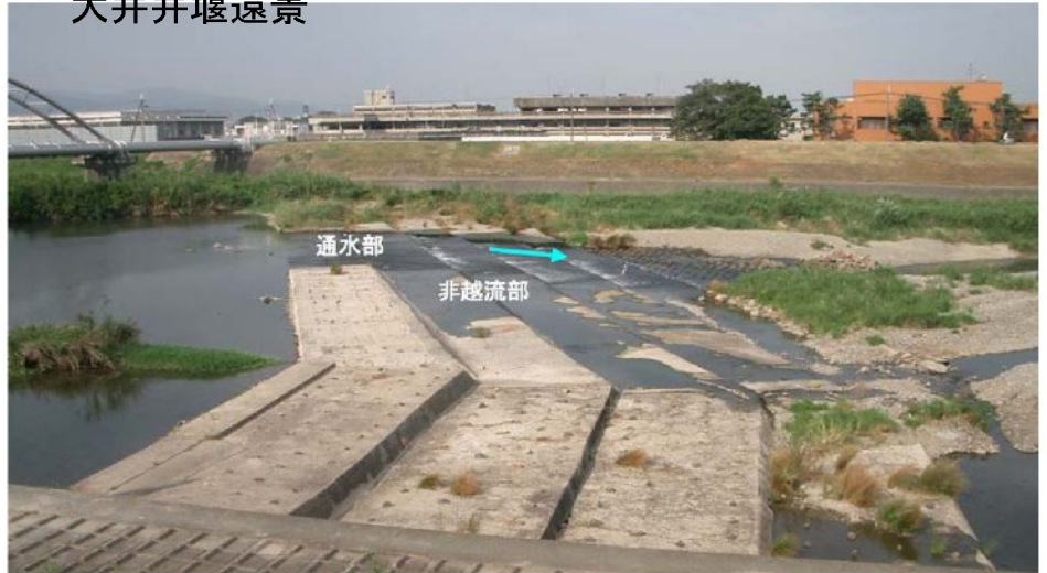
大井井堰遠景
