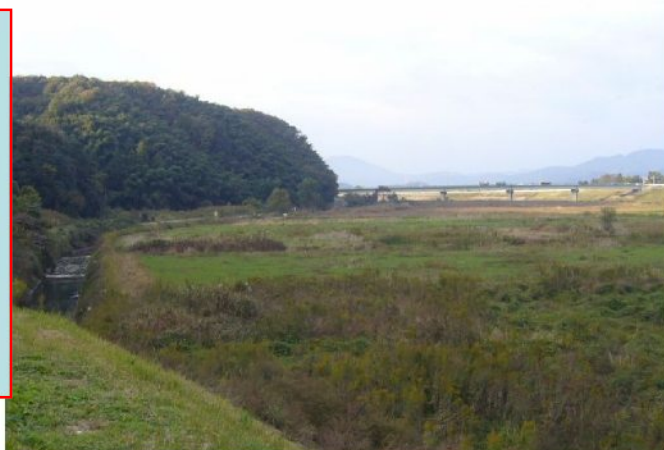
加陽地区(上流より)
