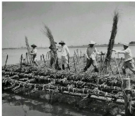
粗朶水制工施行状況
