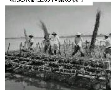
粗朶水制工の作業の様子
