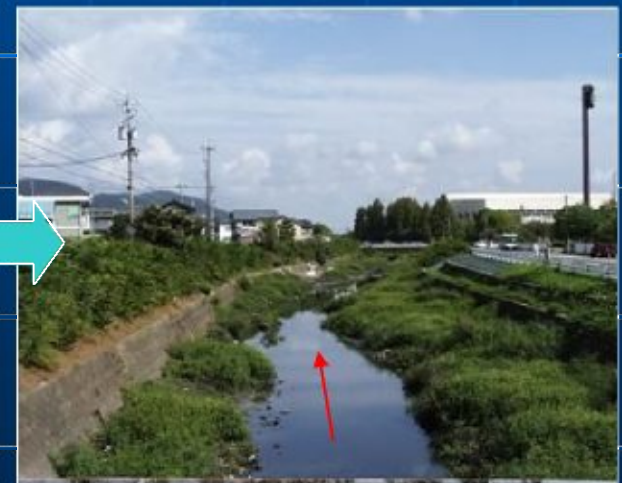
整備後5年経過
