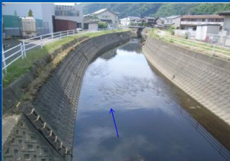
整備前河川状況
