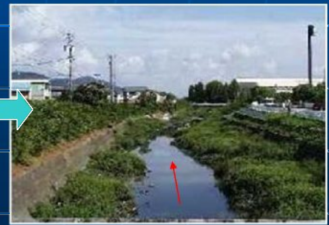
整備後5年経過
