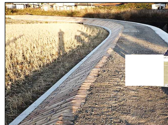
熊井川 丸太伏工
