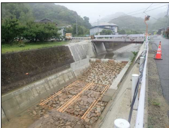
左向谷川 木製沈床工
