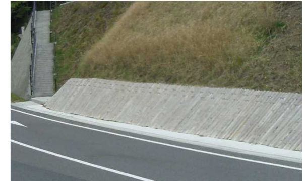
⑥ 丸太伏工[伊都郡高野町 国道480号]
