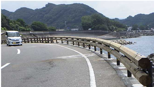
② 木製Gr[有田郡湯浅町 県道 有田湯浅線]
