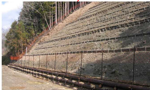
⑤ 丸太筋工[東牟婁郡古座川町]
