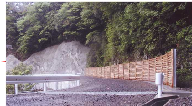
⑦ 木製落石防護柵[田辺市 林道 東の川線]
