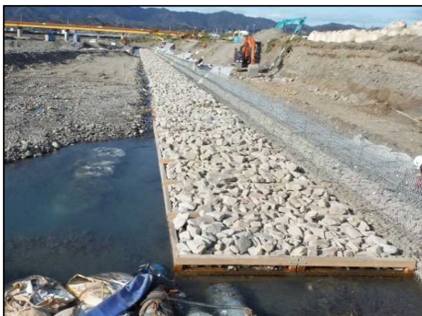
日高川 木製沈床工
