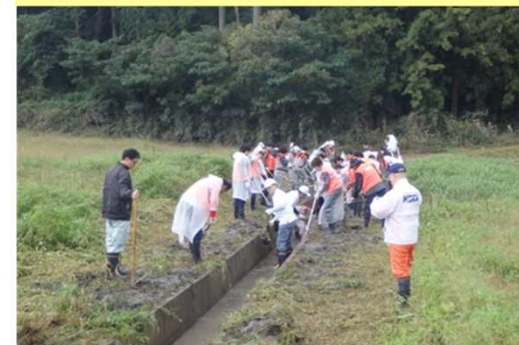
導水路を掃除して頂きました
