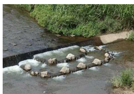
魚道整備(八代水門)
