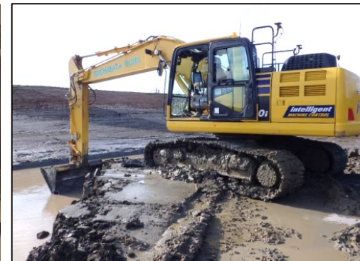
⑧ICTによる現地施工
