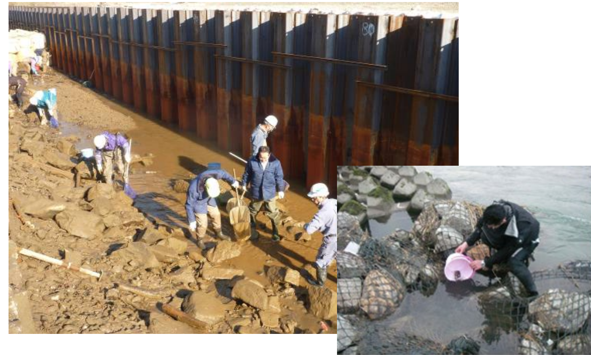
救出作業状況
