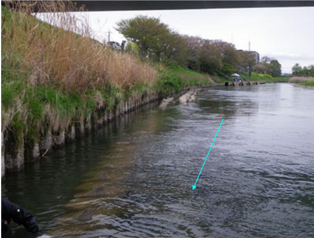
矢板設置状況
