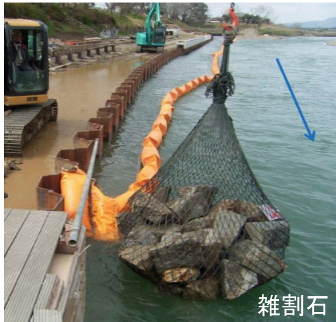
袋型根固めの設置状況
