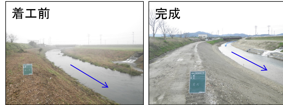
北島桜橋 下流
