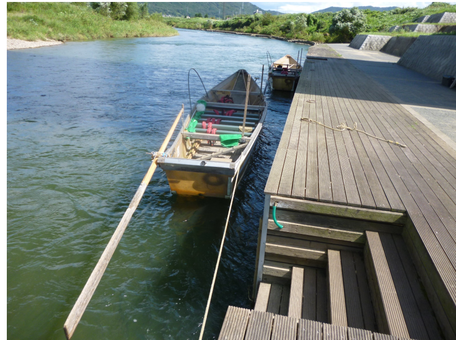
新遊船乗り場(工事後)
