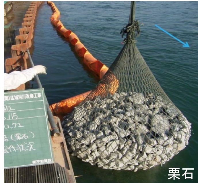
袋型根固めの設置状況
