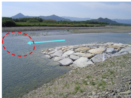
水制工によるシェルター(避難場)の形成例
