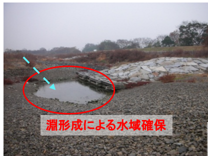
水制工によるシェルター(避難場)の形成例
