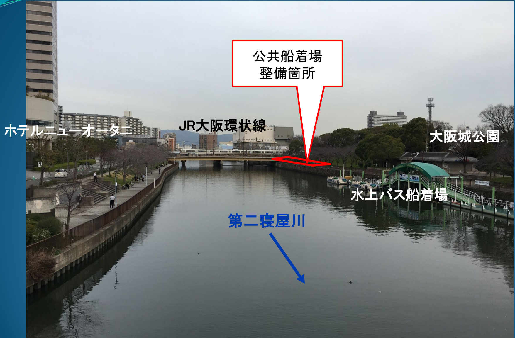
第二寝屋川の橋梁から上流側
