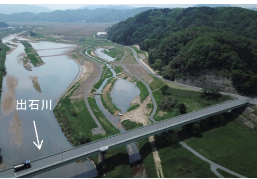
湿地再生(加陽地区)の完成写真(H31.5撮影)
