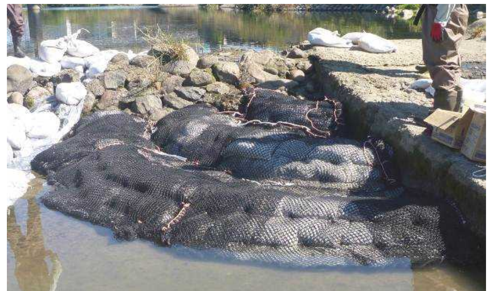
完成した簡易魚道
