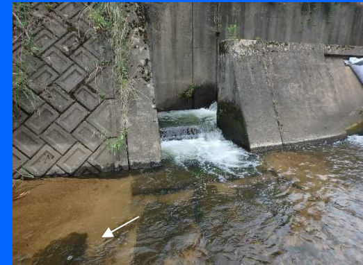
整備前の改良箇所
