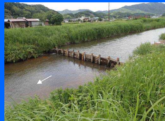
整備前の施設
