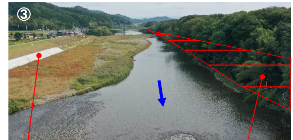
既設護岸 掘削範囲(タイプ①)
