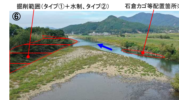
既設護岸 掘削範囲(タイプ②)
