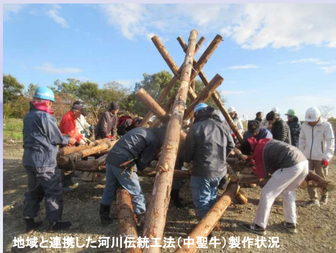
木津川への中聖牛、竹蛇籠設置状況
