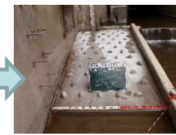
採取した植石の設置作業
