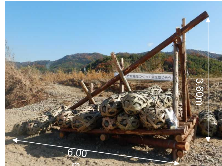
図-木津川に設置した中聖牛
