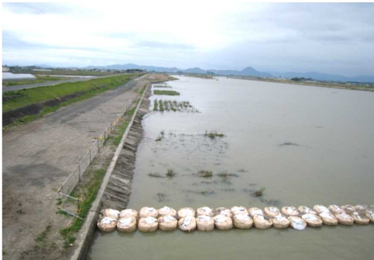
H22.4.23(施工直後)
