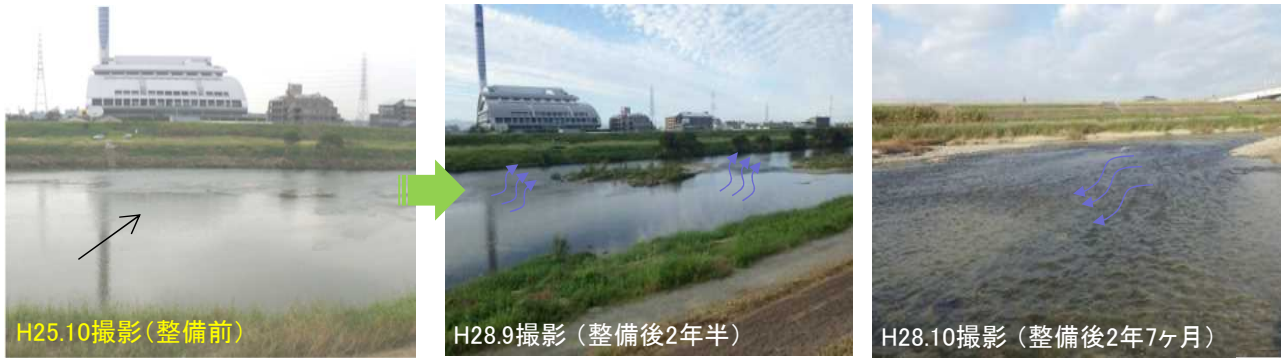
瀬の整備箇所(瓜破大橋下流:H25年度整備)
