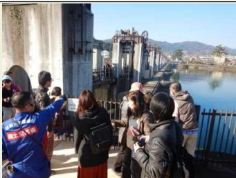
■普段は見られない洗堰ツアー
