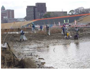
ゴミの収集作業状況
