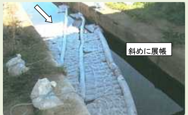
現場での吸着式オイルフェンス設置例
