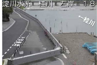
桂川河道掘削 施工前(H27)
