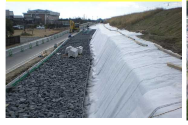
堤防強化(ドレーン工の施工例)
