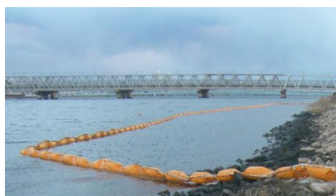
写真 4.2.6-1 工事中の濁水対策の事例 (汚濁防止フェンスの設置) (令和3年1月)
