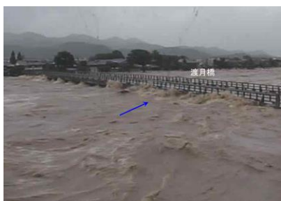
写真 2.2-1 桂川 (平成 25 年台風 18 号)
