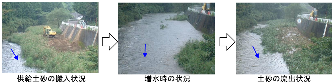
写真 4.2.5-5 布目ダム下流土砂供給試験状況(平成 16 年 9 月)
