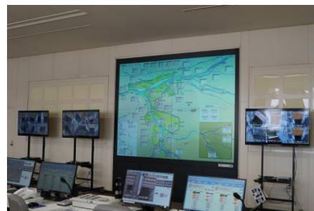
写真 4.6.2-5 上野集中管理センター (令和3年3月)
