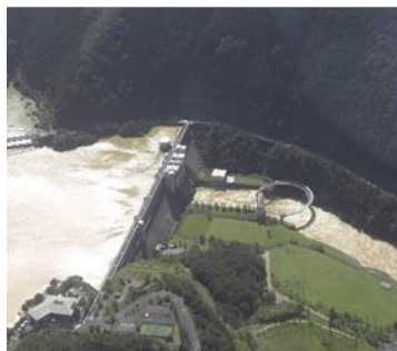
写真 2.2-2 日吉ダム (平成 25 年台風 18 号)
