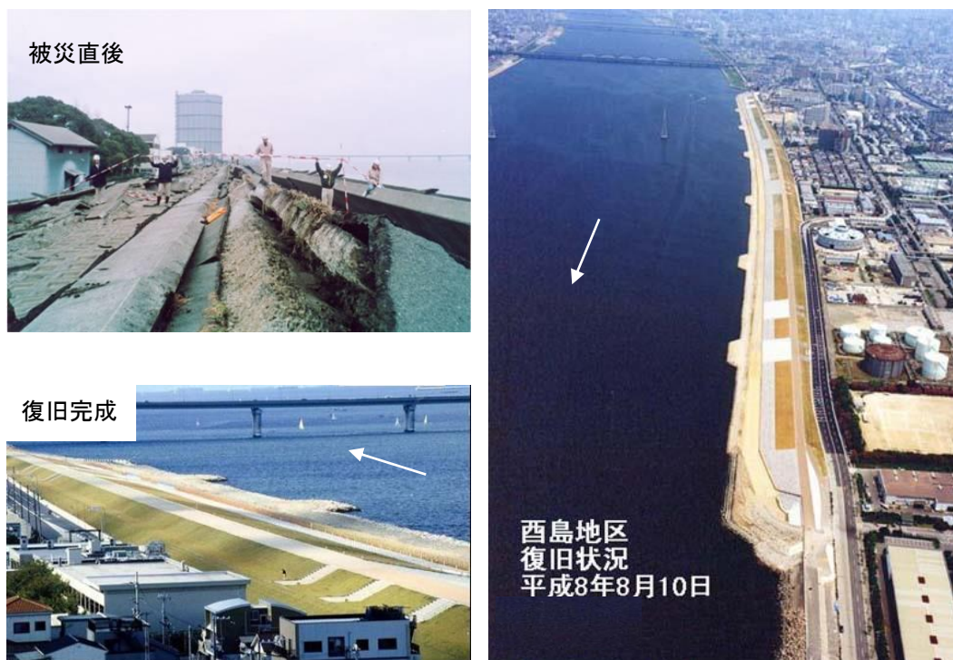
写真 3.3.3-1 西島地区災害復旧工事状況
