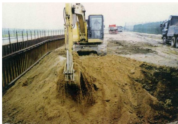
写真 3.3.1-13 木津川の堤防の状況(平成 12 年)
