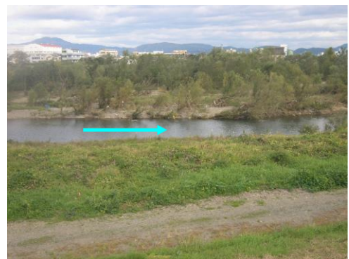
写真3.6-2 河道内樹木の繁茂状況(桂川) (平成30年9月)
