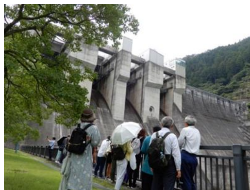
写真 4.1.4-2 日吉ダム見学ツアー (令和元年 8 月)
