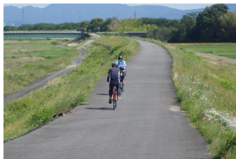
写真 4.1.2-3 堤防天端を通行する自転車 (野洲川)(令和 2 年 12 月)
