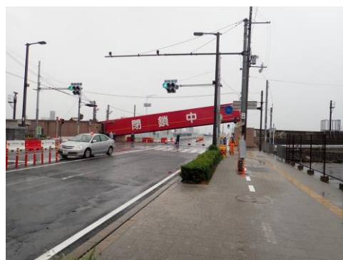
写真 3.3.2-2 淀川陸閘ゲート (平成 30 年 9 月)
