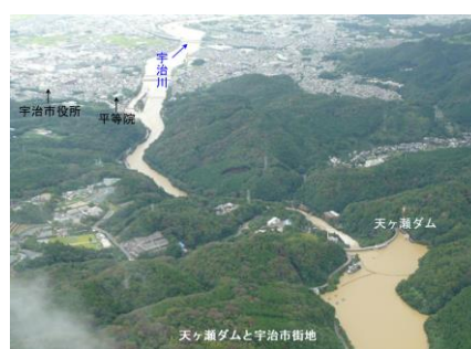
写真 2.2-3 天ヶ瀬ダム (平成 25 年台風 18 号)
