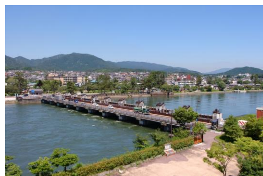
写真 2.3-2 瀬田川洗堰 (平成 19 年 7 月)
