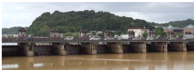
写真 3.3.1-1 瀬田川洗堰全閉操作(平成 25 年台風 18 号)
