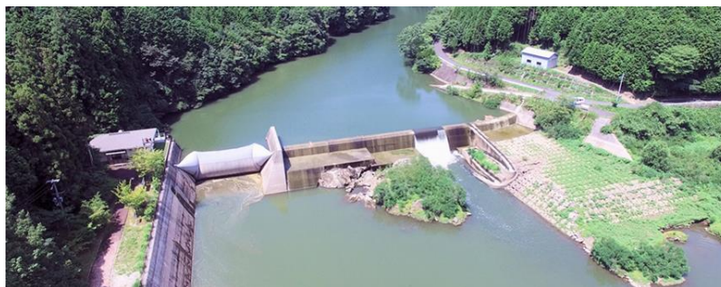
写真 4.2.5-4 副ダム(室生ダム)(平成 29 年 8 月)
