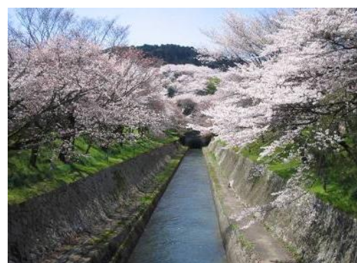
写真 2.3-1 琵琶湖第 1 疏水 (平成 16 年 4 月)
