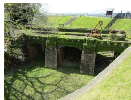
写真 4.6.2-3 毛馬洗堰(重要文化財) (令和 3 年 4 月)
