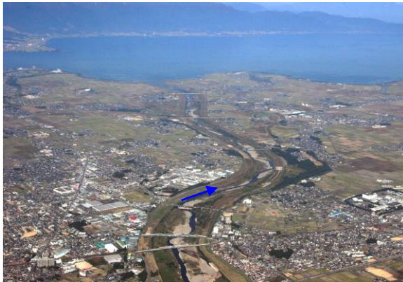
写真 3.3.1-10 野洲川(放水路区間) (平成 19 年 8 月)
