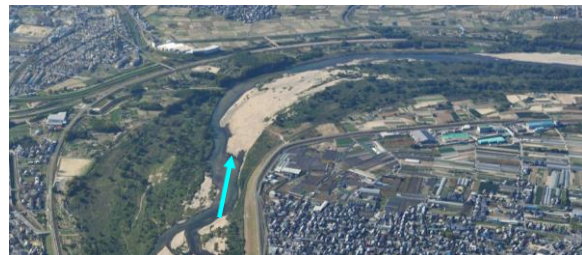
写真 4.2.3-4 砂州河川の再生イメージ(木津川下流) (平成 26 年 11 月)
