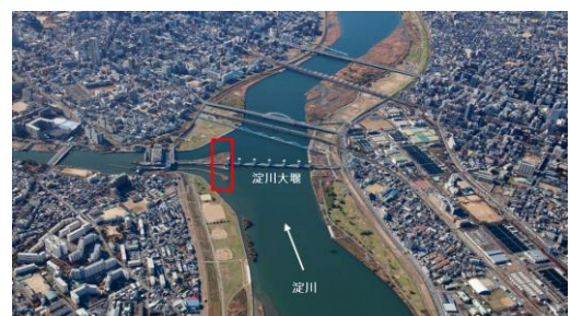
写真 4.3.4-1 淀川大堰閘門設置位置 (平成 26 年 11 月)
