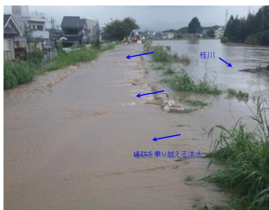
写真 3.3.1-6 久我地区 堤防越水 (平成 25 年台風 18 号)
