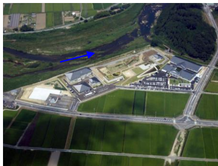
写真 4.3.2-6 名張川河川防災ステーション (平成 24 年 12 月)
