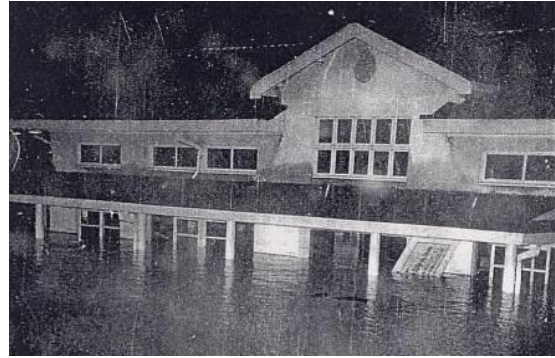
写真 3.3.1-5 亀岡駅 (昭和 28 年 9 月台風 13 号)
