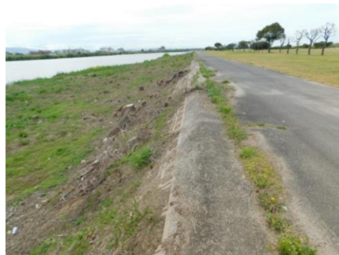
写真 3.2.7-1 コンクリート護岸 (令和3年4月)
