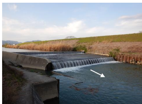
写真 4.2.3-8 縦断方向の河川形状の修復 (芥川1号井堰)(令和3年3月)
