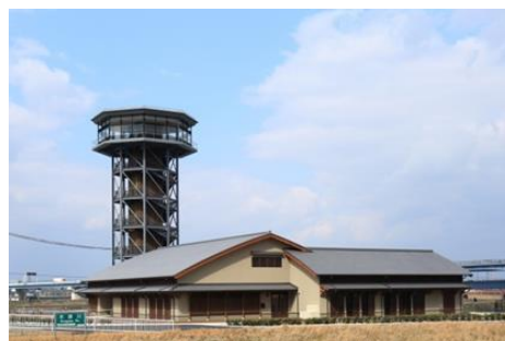
写真 4.1.2-4 さくらであい館 (平成 30 年 12 月)
