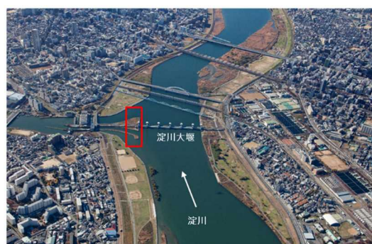
淀川大堰閘門設置位置 (平成26(2014)年11月)
