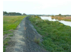
写真 3.2.7-1 コンクリート護岸
