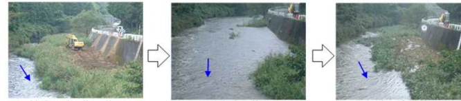
供給土砂の搬入状況 増水時の状況 土砂の流出状況
