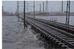
写真 3.3.2-1 昭和36年9号台風時の阪神電鉄西大阪線橋梁の状況
