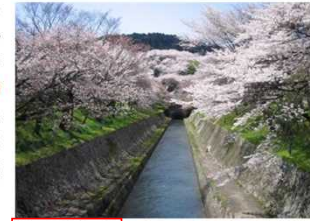
写真2-12 琵琶湖疏水の取水口
