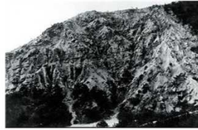
写真 3.3.1-12 三上山の荒廃状況(大正4年)
