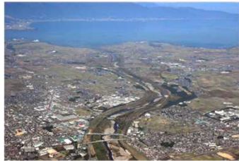
写真 3.3.1-5 野洲川(放水路区間)
