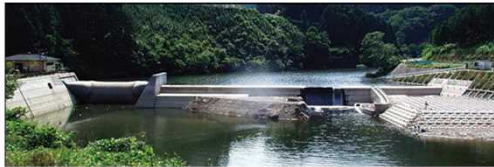
写真 4.2.5-4 副ダム（室生ダム）
