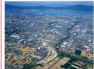
写真 3.3.1-6 草津川(分派部)
