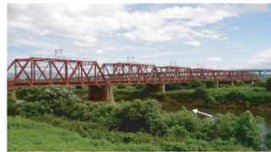
写真 3.6-2 河道内樹木の繁茂状況(木津川)
