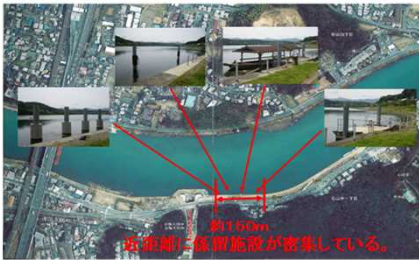
写真 3.2.7-2 瀬田川における係留施設の設置状況 (右岸 73.1km 付近)
