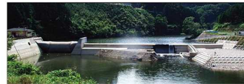
写真 4.2.5-4 副ダム（室生ダム）
