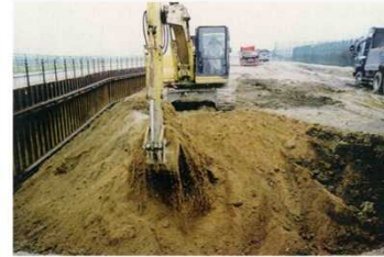
写真 3.3.1-13 木津川の堤防の状況
