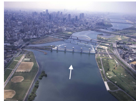
写真 3.2.3-1 淀川大堰から下流を望む
