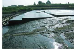
写真 3.2.1-1 魚類等の遡上・降下の阻害となっている横断工作物 高木井堰（猪名川）
