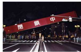
写真 3.3.2-2 淀川陸閘ゲート
