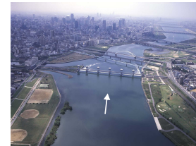
写真 3.2.3-1 淀川大堰から下流を望む
