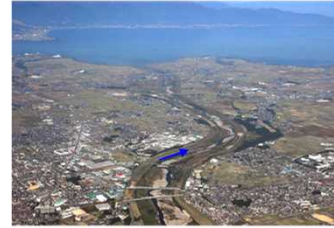
写真 3.3.1-10 野洲川(放水路区間)
