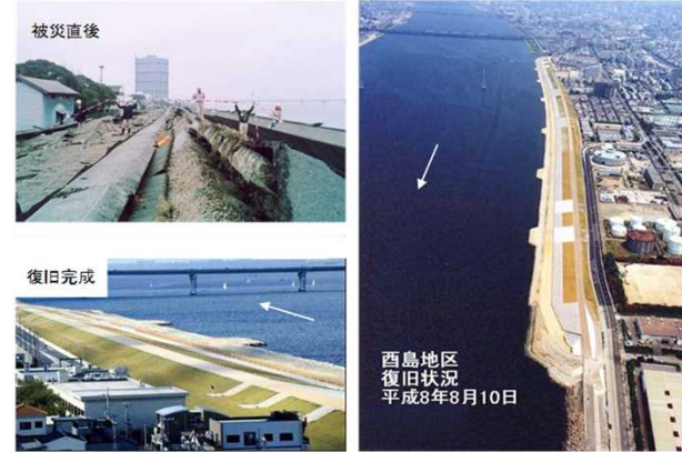
写真 3.3.3-1 西島地区災害復旧工事状況
