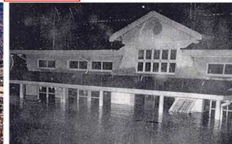
写真 3.3.1-5 亀岡駅 (昭和28年9月台風13号)
