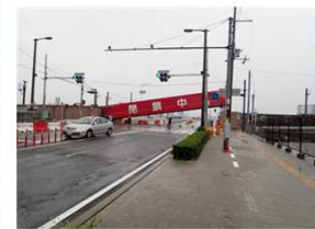
写真 3.3.2-2 淀川陸閘ゲート (平成30年9月)
