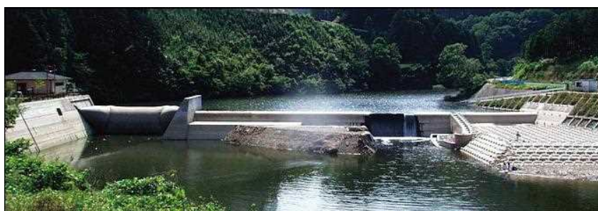
写真 4.2.5-4 副ダム（室生ダム）
