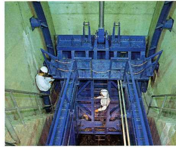
ゲートの点検状況
