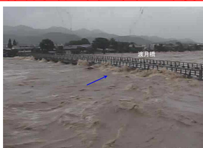
写真 2-9 桂川 (平成 25 年台風 18 号)
