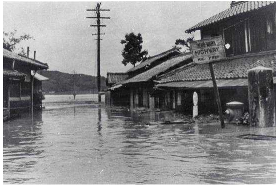
写真 3.3.1-3 伊賀市街(旧上野市)
