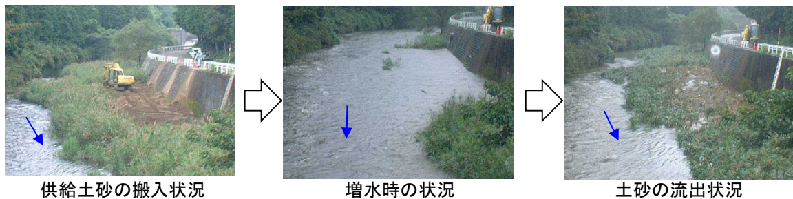
写真 4.2.5-5 布目ダム下流土砂供給試験状況
