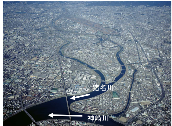
写真 2-9 猪名川・神崎川合流部
