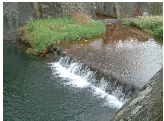
写真 4.2.3-9 瀬田川 流入支川合流部
