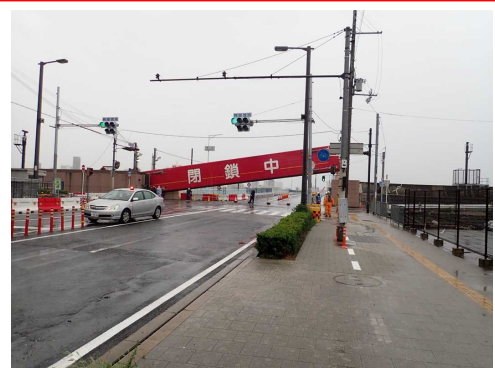
写真 3.3.2-2 淀川陸閘ゲート (平成30年9月)
