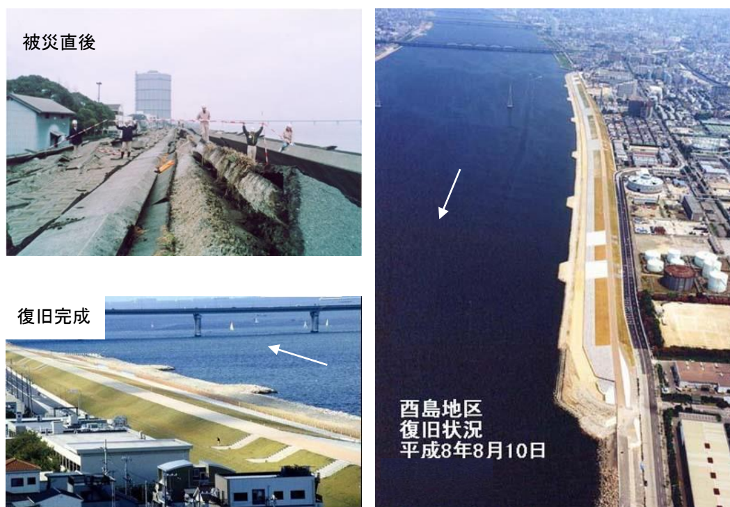
写真 3.3.3-1 西島地区災害復旧工事状況
