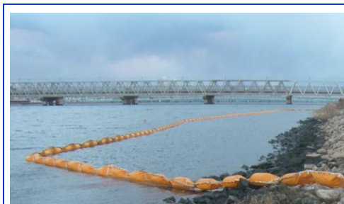
写真 4.2.6-1 工事中の濁水対策の事例 (汚濁防止フェンスの設置) (令和3年1月)
