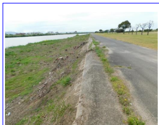
写真 3.2.7-1 コンクリート護岸 (令和3年4月)
