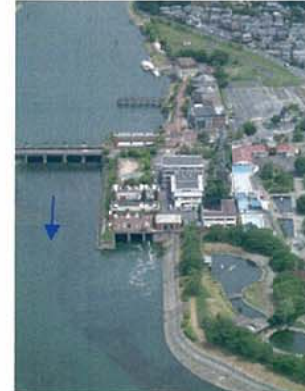
写真 4.3.2-8 瀬田川洗堰のバイパス水路 (写真 4.3.2-8)
