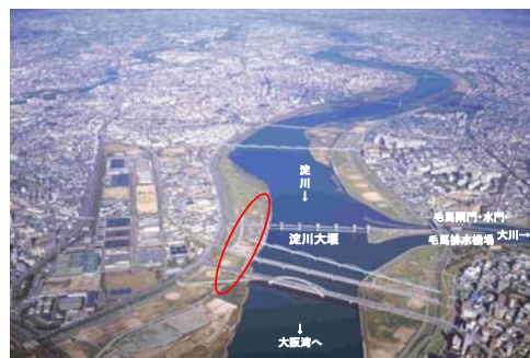
写真 4.3.4-1 淀川大堰閘門設置位置
