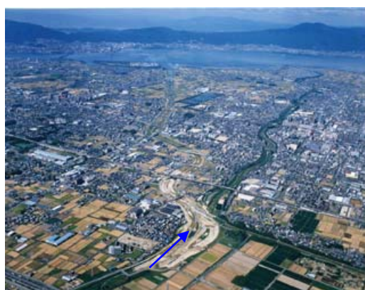
写真 3.3.1-6 草津川(分派部)
