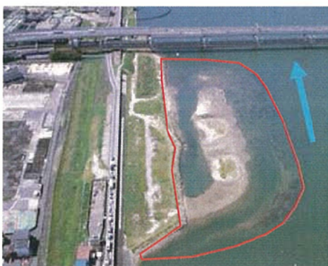
写真4.2.3-3 干潟再生(海老江地区の事例)
