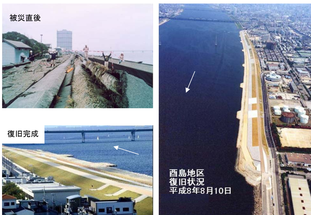
写真 3.3.3-1 西島地区災害復旧工事状況
