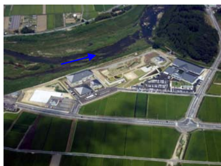
写真 4.3.2-4 名張川河川防災ステーション
