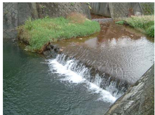
写真 4.2.3-9 瀬田川 流入支川合流部
