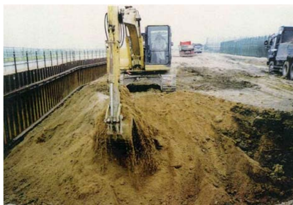
写真 3.3.1-9 木津川の堤防の状況
