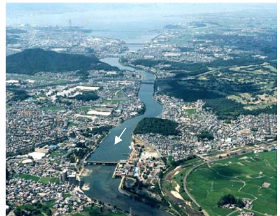
写真2-3 瀬田川(琵琶湖～瀬田川洗堰付近)
