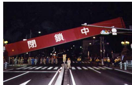
写真 3.3.2-2 淀川陸閘ゲート
