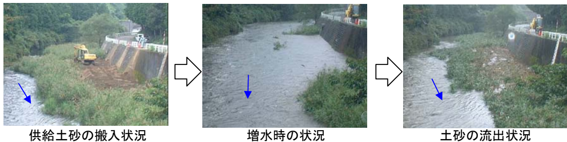
写真 4.2.5-5 布目ダム下流土砂供給試験状況
