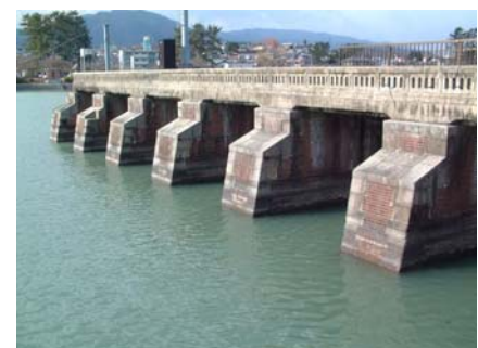
写真 4.6.2-4 旧瀬田川洗堰(南郷洗堰)
