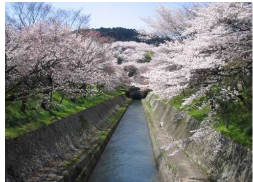
写真2-10 琵琶湖疏水の取水口
