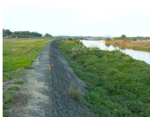
写真 3.2.7-1 コンクリート護岸
