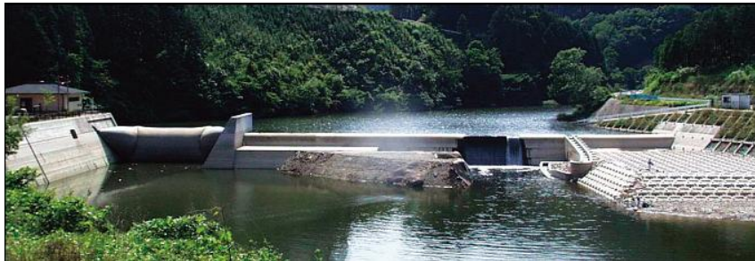
写真 4.2.5-4 副ダム（室生ダム）
