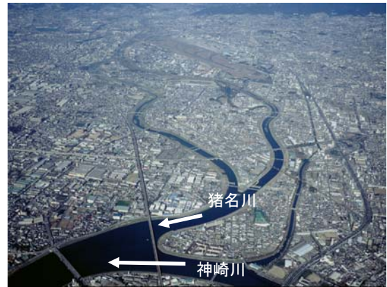
写真 2-9 猪名川・神崎川合流部
