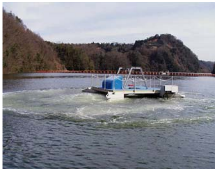
写真 4.2.5-3 循環曝気設備稼働状況
