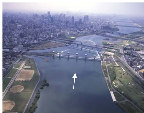
写真 3.2.3-1 淀川大堰から下流を望む
