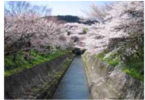
写真 2-10 琵琶湖疏水の取水口(大津側)
