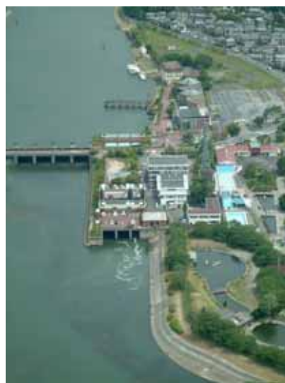
写真 4.3.3-3 瀬田川洗堰のバイパス水路
