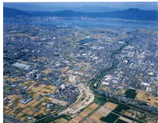
写真 3.3.1-6 草津川（旧川と新川の分派部の様子）
