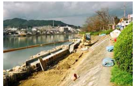
写真 4.2.8-1 工事中の濁水対策の事例 (汚濁防止フェンスの設置)
