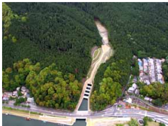
写真 4.3.3-6 大津放水路（瀬田川合流部）
