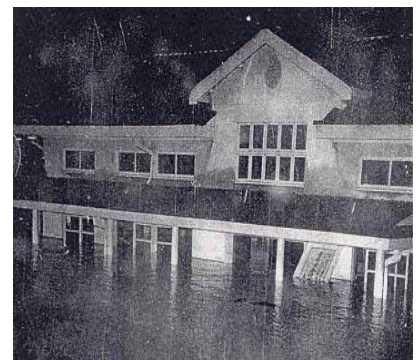
写真 3.3.1-4 亀岡駅 (昭和28年9月台風13号)
