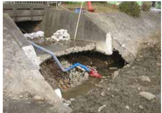
写真 3.6-1 護岸空洞化の状況写真(平成 19 年 1 月に瀬田川で発見されたもの)
