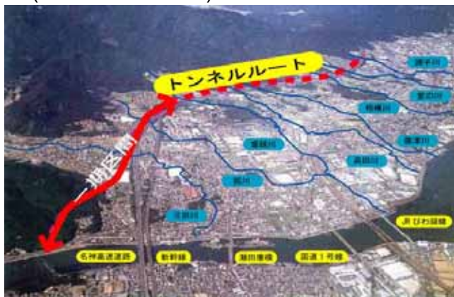
写真 4.3.3-5 大津放水路と流入河川
