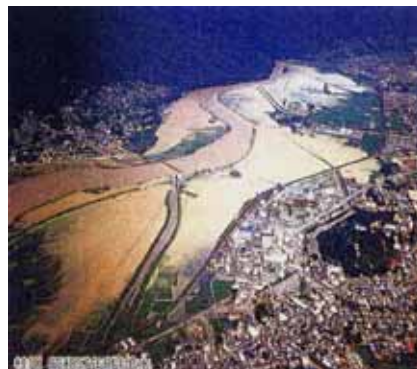
写真 3.3.1-3 亀岡市街上空から (昭和57年8月台風10号)
