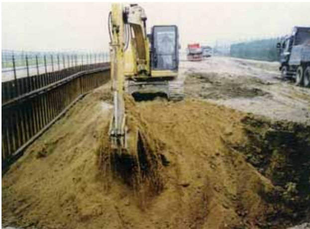
写真 3.3.1-9 木津川の堤防の状況
