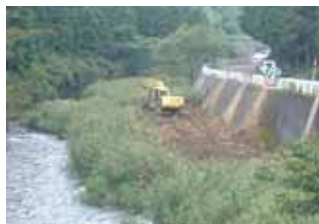
土砂置土整地状況
