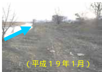
写真 4.2-6 試験施工実施前
