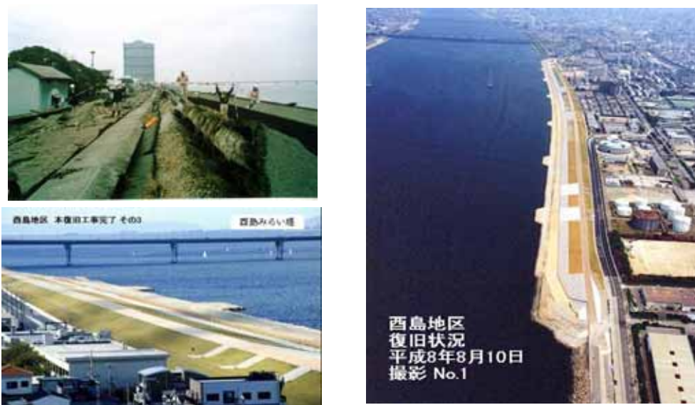
写真 3.3.3-1 西島地区災害復旧工事状況
