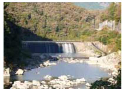
写真4.2-12大河原発電所井堰（木津川）
