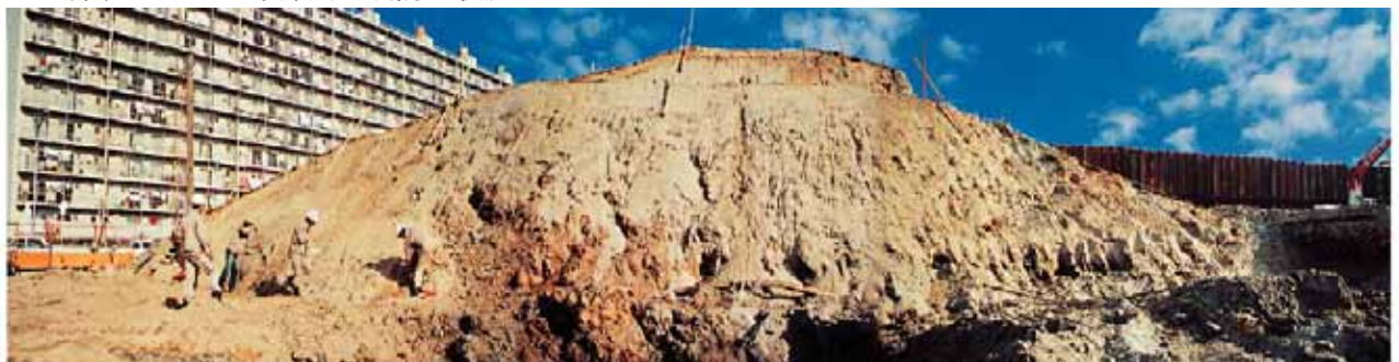
工事で開削された堤防断面。土砂だけで積み上げられていたのがよくわかる
