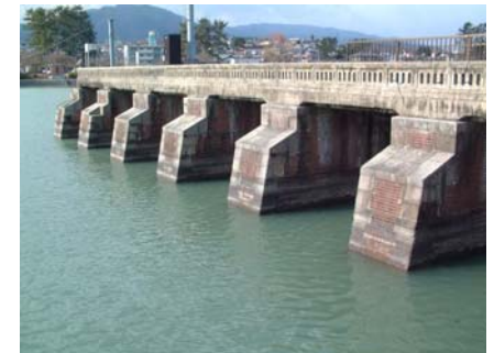
写真 4.6.2-4 旧瀬田川洗堰(南郷洗堰)
