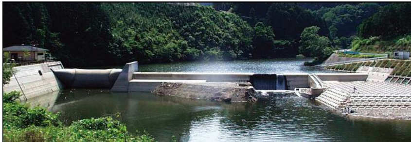
写真 4.2.5-4 副ダム（室生ダム）
