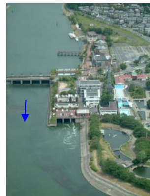
写真 4.3.2-8 瀬田川洗堰のバイパス水路
