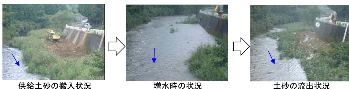
写真 4.2.5-5 布目ダム下流土砂供給試験状況
