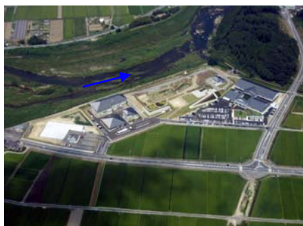
写真 4.3.2-4 名張川河川防災ステーション
