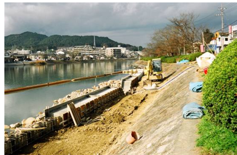
写真 4.2.6-1 工事中の濁水対策の事例 (汚濁防止フェンスの設置)
