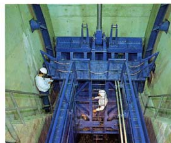
ゲートの点検状況
