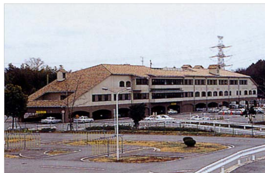
猪名川流域でのピロティ構造の事例
