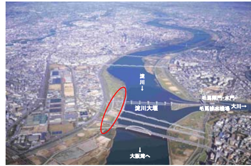
写真 4.3.4-1 淀川大堰閘門設置位置
