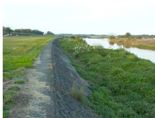
写真 3.2.7-1 コンクリート護岸
