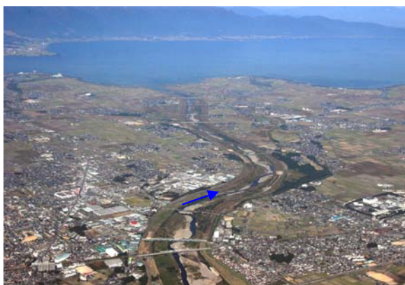
写真 3.3.1-5 野洲川(放水路区間)
