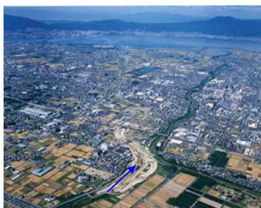
写真 3.3.1-6 草津川(分派部)
