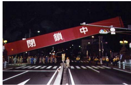
写真 3.3.2-2 淀川陸閘ゲート
