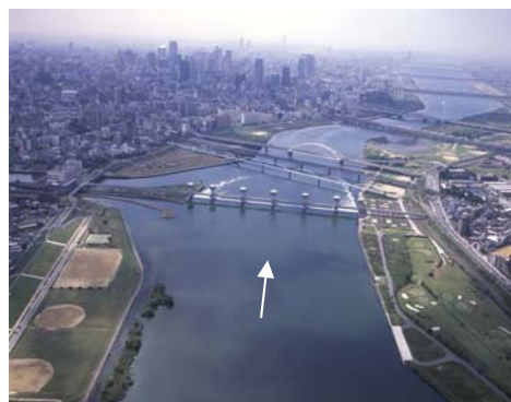
写真 3.2.3-1 淀川大堰から下流を望む
