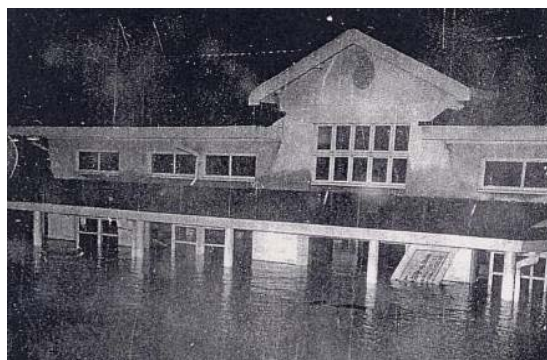
写真 3.3.1-4 亀岡駅 (昭和28年9月台風13号)
