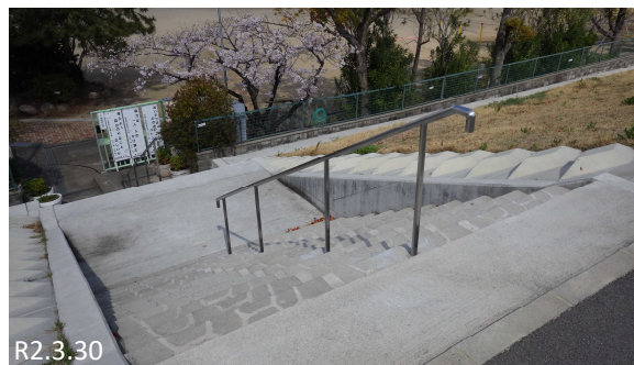
新設された手摺り(R1)
