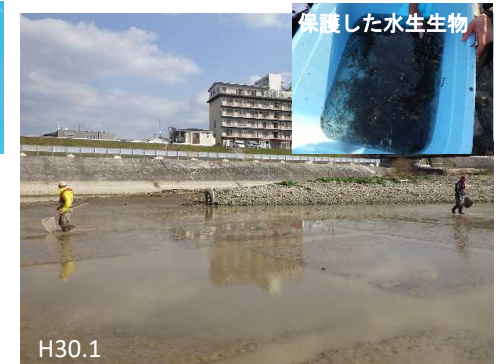
4号井堰左岸側の締め切り状況
