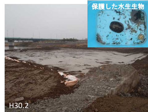
4号井堰右岸側の締め切り状況
