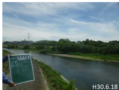
利倉・岩屋地区河道掘削(H29・H30)
