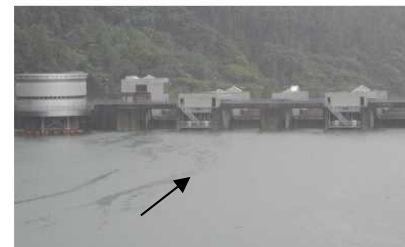
洪水時最高水位に近く貯水池の状況 (7月6日10時)
