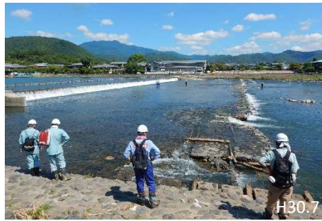
平成30年7月豪雨直後の合同現地調査
