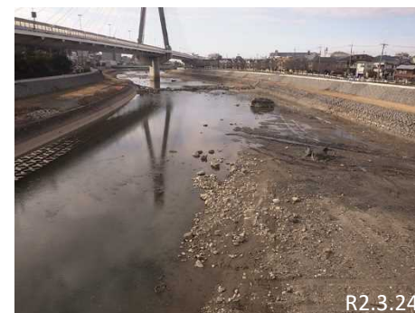
小戸・木部地区河道掘削(R1)
