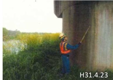
東海道新幹線桂川橋(東海旅客鉄道)
