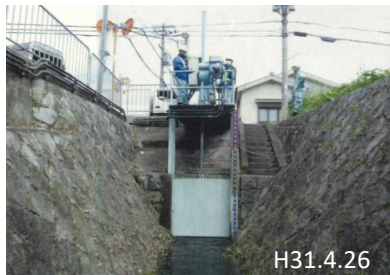
梅津第一排水樋門(京都市)
