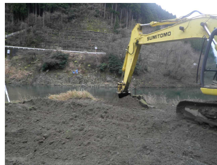
堆砂除去状況 (R2.3)
