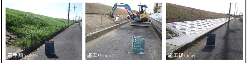
■施工写真(猪名川右岸1.2k付近)
