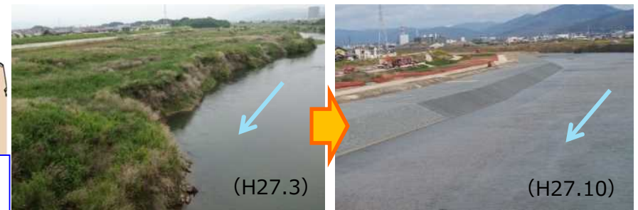
羽束師橋上流の掘削状況
