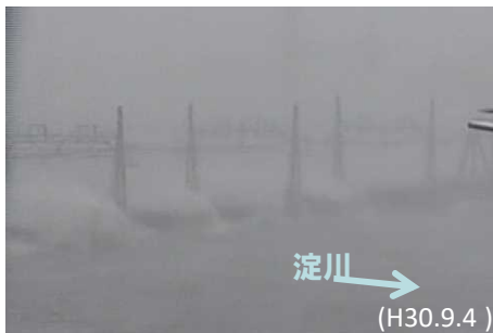
平成30年台風21号の高潮による 阪神なんば線淀川橋梁の橋桁の越波状況 (H30.9.4)
