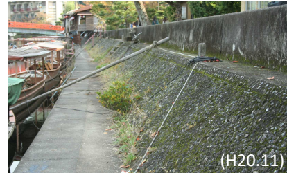
塔の川(改修前)
