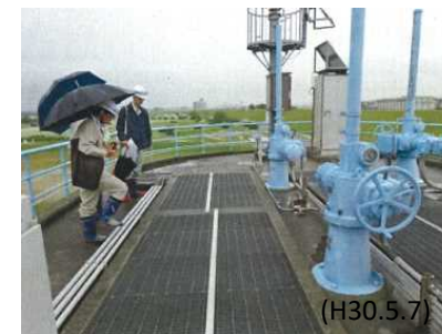
大庭取水口における合同点検 (淀川 大阪広域水道企業団)
