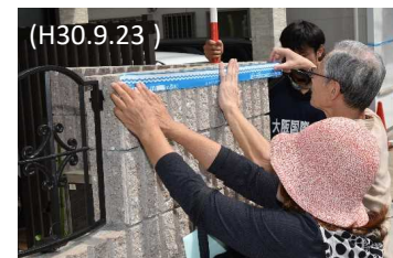
浸水位テープ貼付状況
