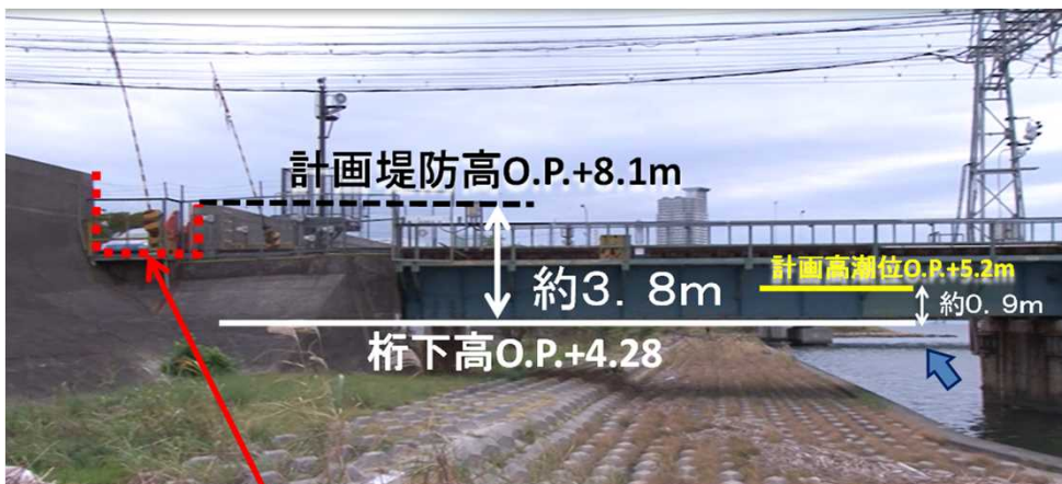
橋梁部分は堤防切り欠き
