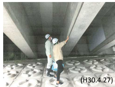
一津屋新橋における合同点検 (淀川 摂津市)
