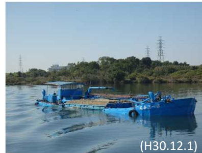
砂利採取業者による堆積土砂の掘削(枚方大橋付近)
