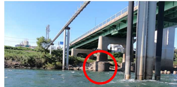
橋脚の基礎の露出(観月橋)
