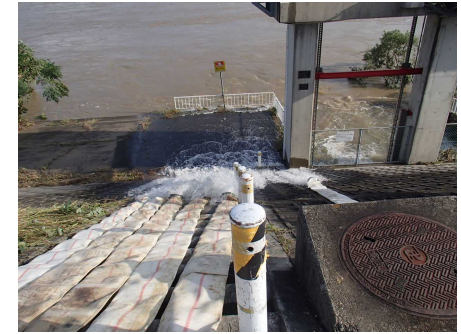
久保田樋門での排水作業状況
