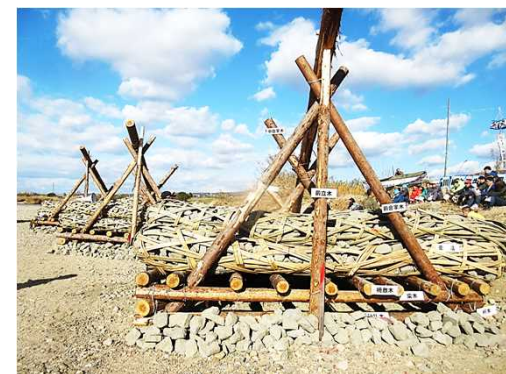
石や竹蛇籠を積み上げて設置
