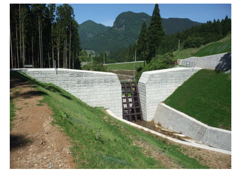
名張川支川太良路川【太良路川砂防えん堤】(平成27年度完成)
