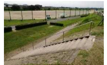
新設された手摺り(H28)
