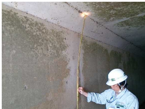
樋門・樋管の点検 (新川樋門)
