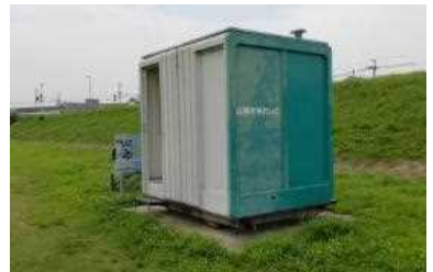
公園に設置されているトイレ
