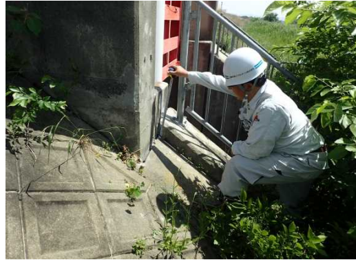
樋門点検状況 (大山崎樋門、H28年11月)
