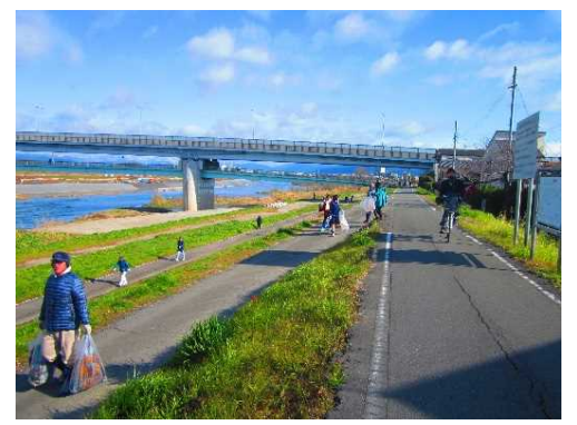
羽束師橋左岸地点
