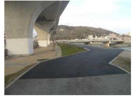
舗装改修実施箇所 (H27)
