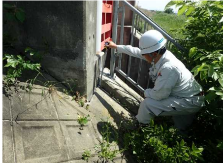
樋門点検 (大山崎樋門、H28年11月)
