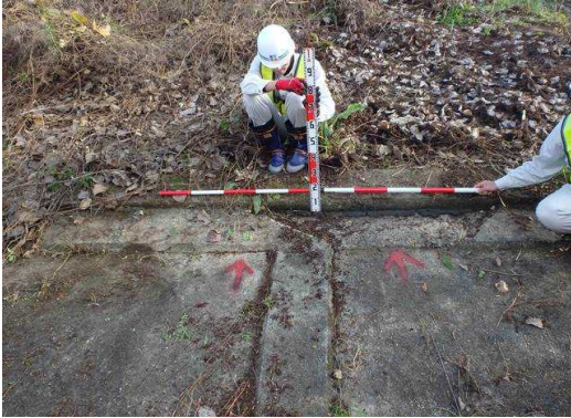
堤防点検状況 (桂川左岸3.2km、H28年11月)
