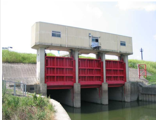
西羽束師樋門
