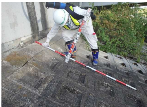
護岸の点検 (桂川右岸12.2km)
