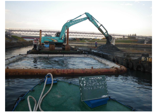
戸ノ内地区河道掘削(H28)
