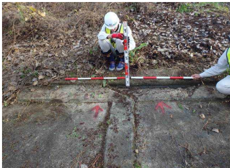
堤防点検 (桂川左岸3.2km、H28年11月)
