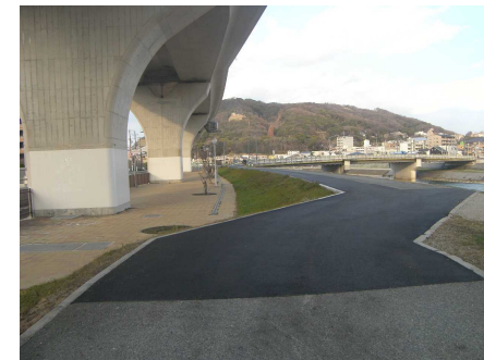
舗装改修実施箇所 (H27)
