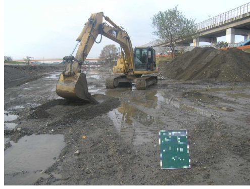
川西・池田地区河道掘削(H27)
