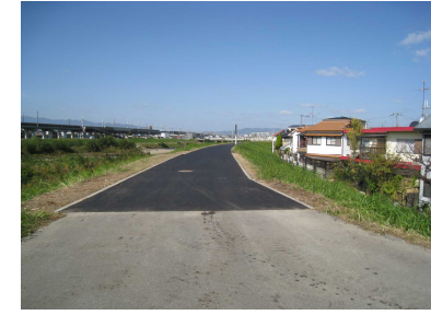
天端舗装(藻川1.4K付近) [H28]
