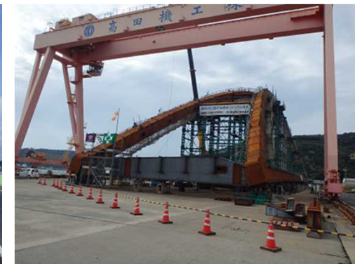
【仮組立検査状況(H28)】
