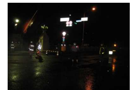
右岸陸間閉鎖中の状況
