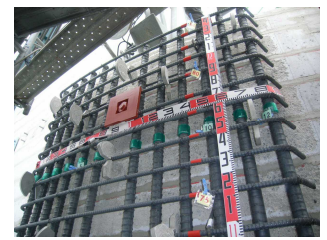
淀川大堰 堰柱耐震対策実施状況
