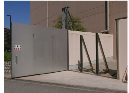
発電機棟防潮扉
