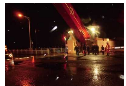
左岸陸間閉鎖中の状況
