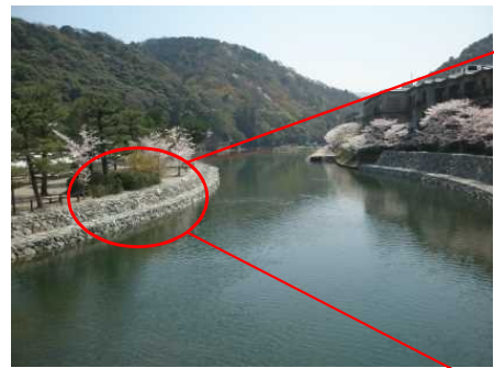
川底に石を敷いて隙間を作り、ナカセコカワニナに配慮
