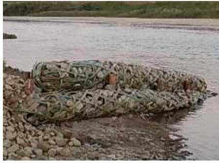
竹蛇籠の設置状況
