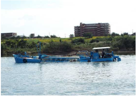
砂利採取業者による堆積土砂の掘削
