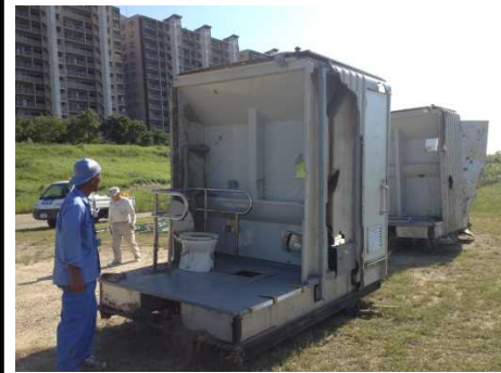
平成25年9月出水等により破損等 で使用できなくなったトイレ
