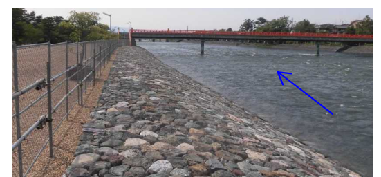
塔の島護岸施工状況
