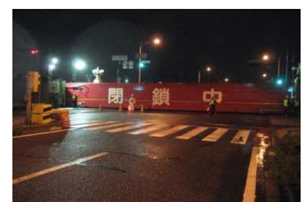
右岸陸間閉鎖後の状況
