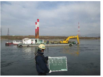
堆積土砂除去
