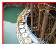
流入部 (鋼管矢板打設)
