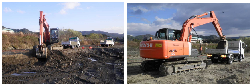
平成27年度試験施工状況
