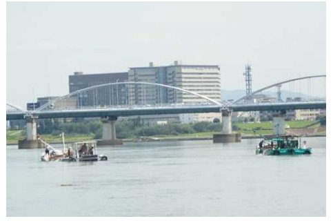
砂利採取業者による堆積土砂の掘削
