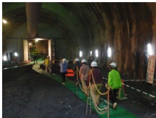
天ヶ瀬ダム再開発トンネル
