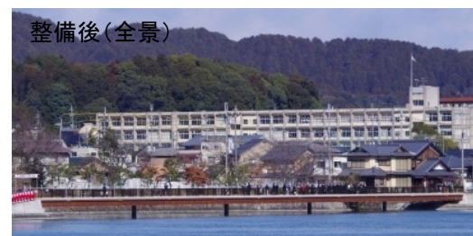
瀬田川(大津市南郷町1丁目から4丁目)の小径整備 平成27年2月に橋梁完成(0.11km)
