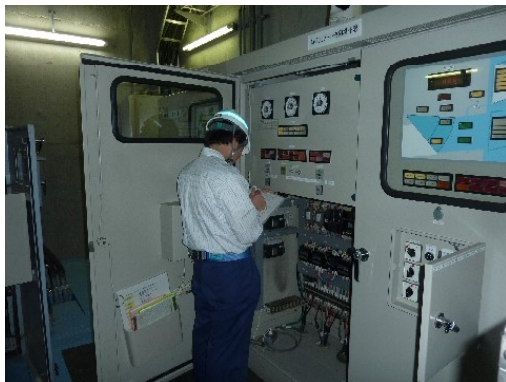
機械設備の点検
