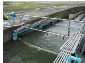
カメラによるモニタリング状況
