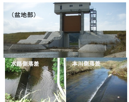
写真-1 支川との落差の例(上野遊水地)
