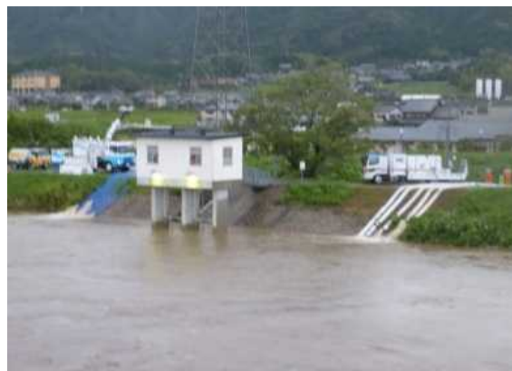
伊賀市所有排水ポンプ車と協働での排水状況
