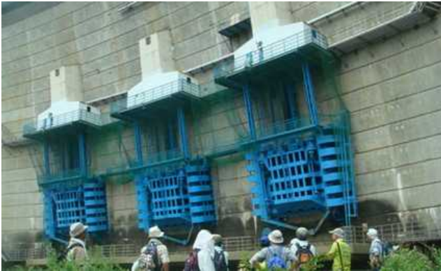
天ヶ瀬ダムにおける住民協働の取り組み
