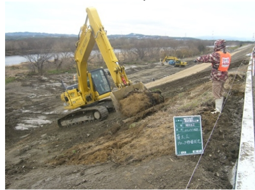
③表土の復元状況
