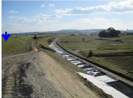
施工中(ドレーン工設置)
