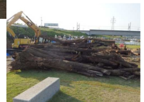
(補修完了(樹木撤去))
