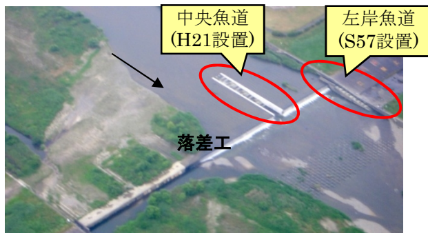
魚道の設置状況
