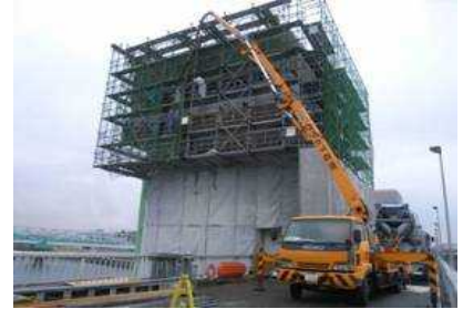
淀川大堰補修状況
