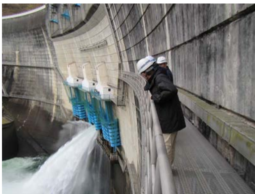
現地確認状況(主要河川管理施設総合点検)
