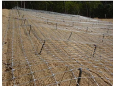
施工直後の状況(平成25年)
