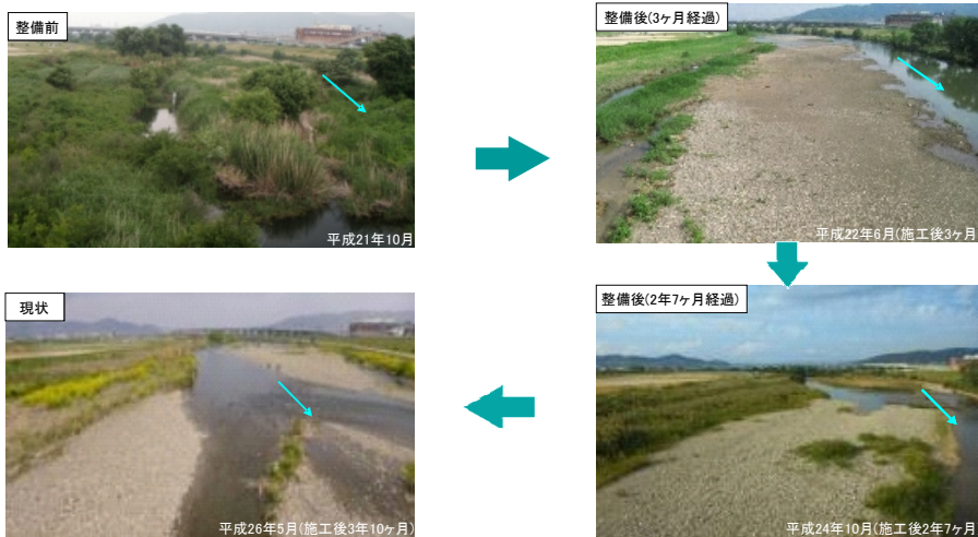
北伊丹地区礫河原再生状況
