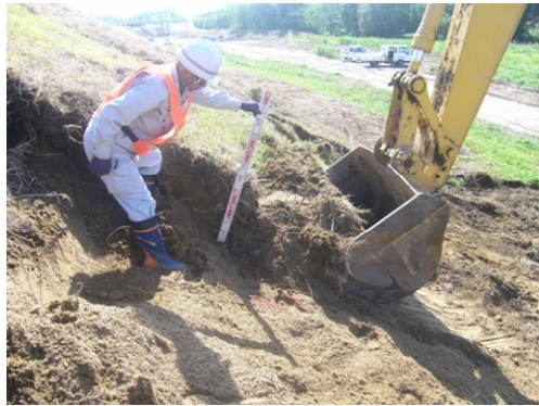
①表土の剥ぎ取り状況
