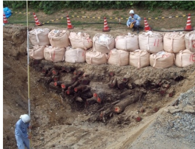
(補修状況(埋設状況確認))
