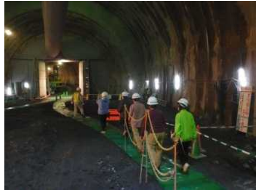
天ヶ瀬ダム再開発トンネル
