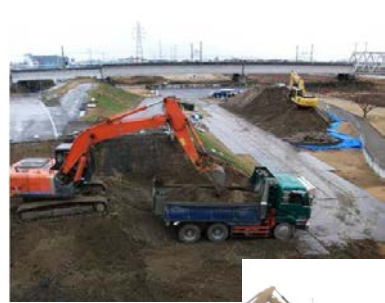
(補修状況(堤防開削))
