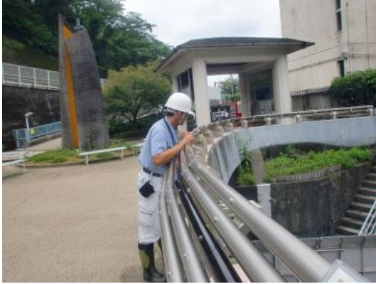
【堤頂からの巡視状況】
