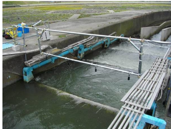
カメラによるモニタリング状況
