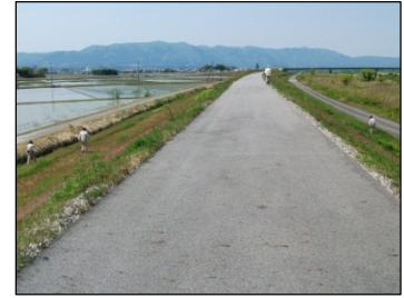
③ 直営堤防点検状況
