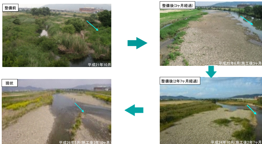
北伊丹地区礫河原再生状況
