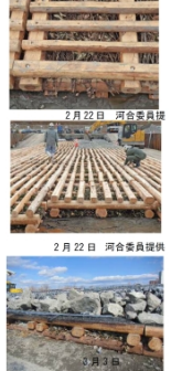
木工沈床工の施工状況写真
