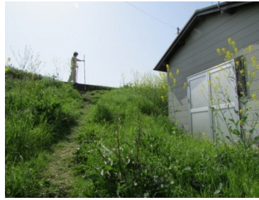
H25点検状況
