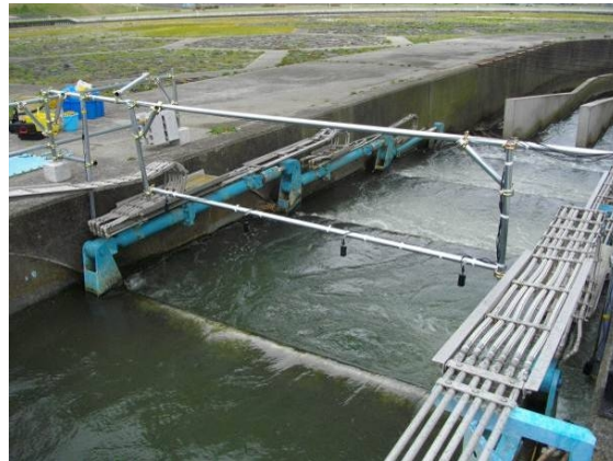
カメラによるモニタリング状況
