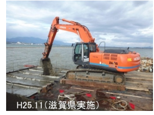
③覆砂として土砂を湖底へ投入 <草津市下笠沖地先>
