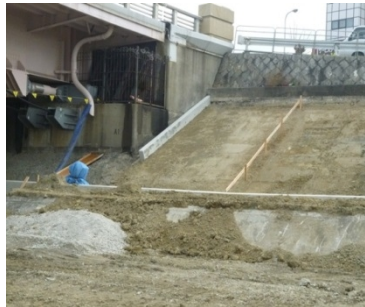
補修工事状況
