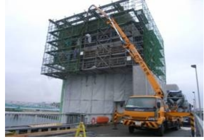
淀川大堰補修状況
