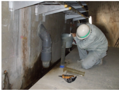
継目排水孔からの漏水量の計測
