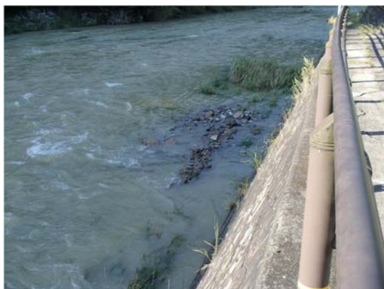
置土状況 出水による流出 (H25.9.19撮影、比奈知ダム下流)
