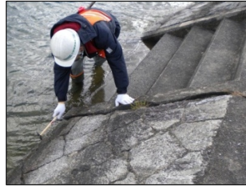
② 堤防・構造物点検状況
