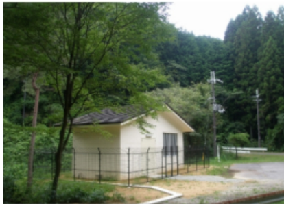
室生ダム曝気設備上屋(貯水池中流)
