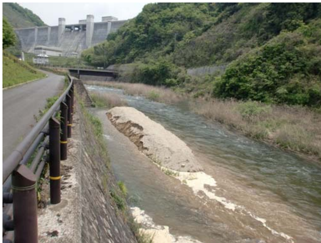
置土状況 フラッシュ放流中 (H23.5.17 撮影、比奈知ダム下流)
