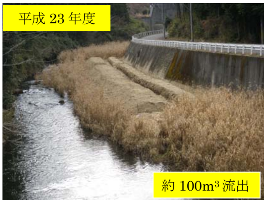
布目ダム出水後の土砂状況（整形後）
