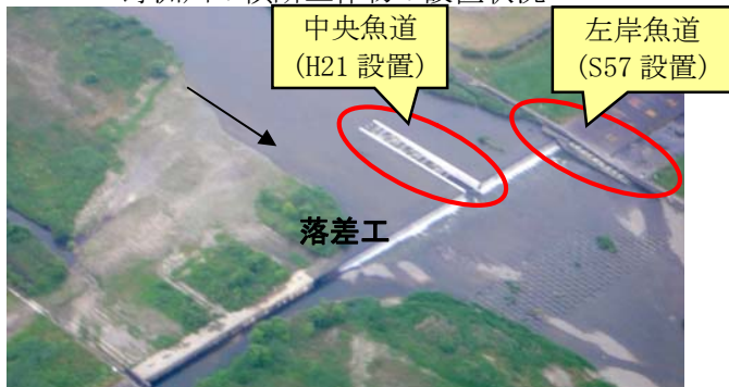
魚道の設置状況
