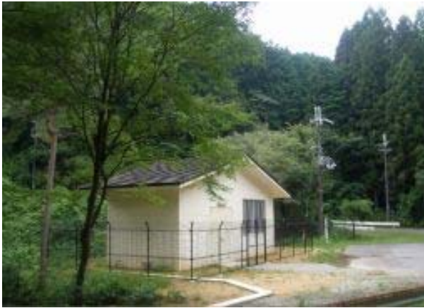
室生ダム曝気設備上屋（貯水池中流）
