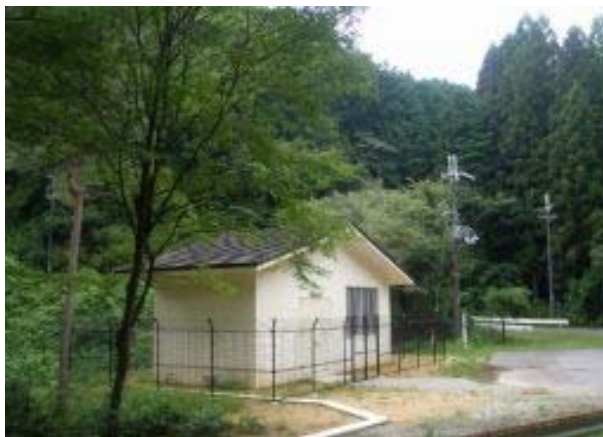
室生ダム曝気設備上屋(貯水池中流)
