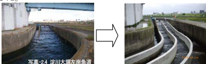
写真-24 淀川大堰左岸魚道
