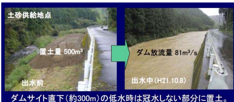
布目ダム自然出水中の土砂の状況(平成 21 年 10 月 8 日)
