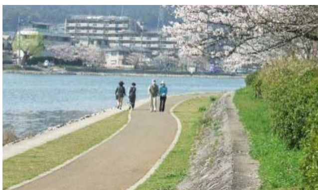
瀬田川散策路整備状況(大津市稲津 1 丁目地先)
