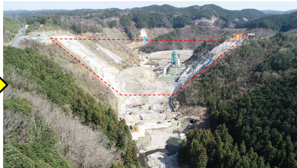
平成31年4月：基礎掘削完了
