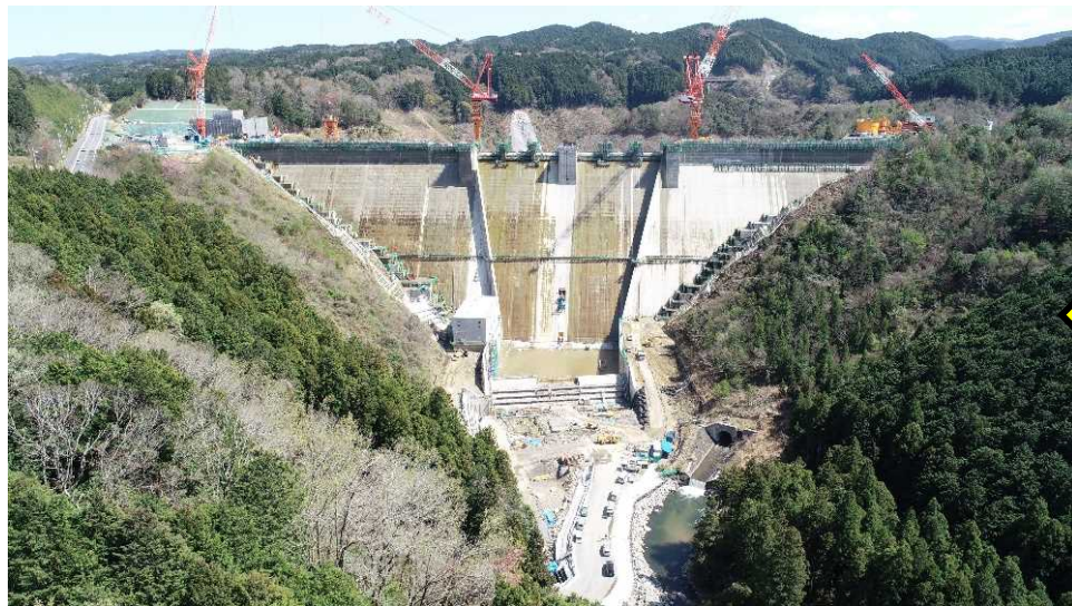
令和3年4月：ダム堤体打設完了
