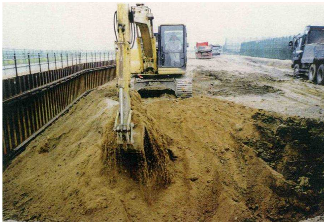
砂でできた脆弱な堤防（木津川）
