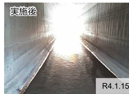
樋門内の堆積土砂撤去前後
