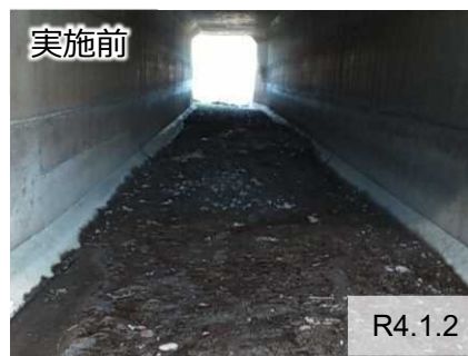
樋門内の堆積土砂撤去前後
